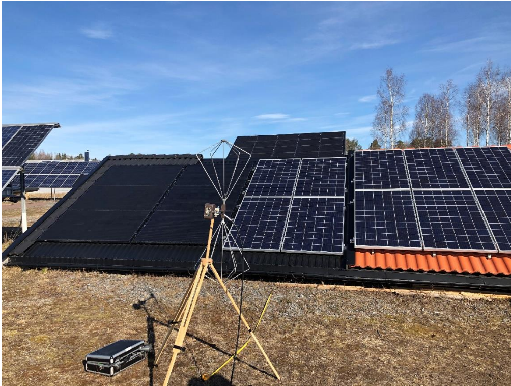
Figur 11: Bikonantenn på stativ framför solpaneler.
